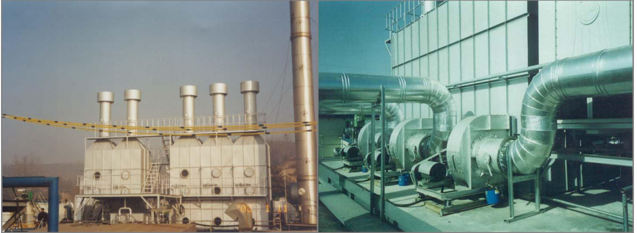
준 공사 진
