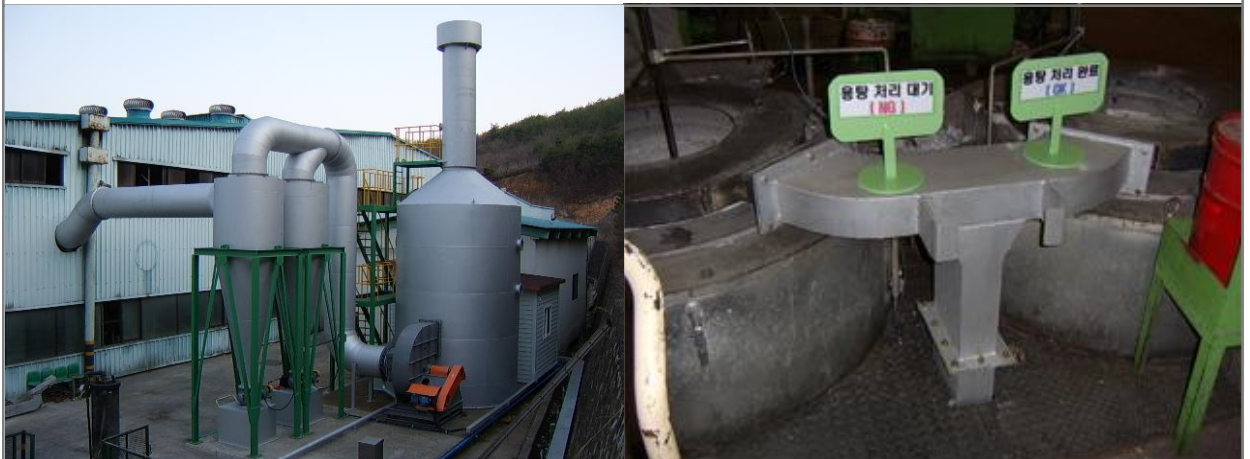
준 공사 진
