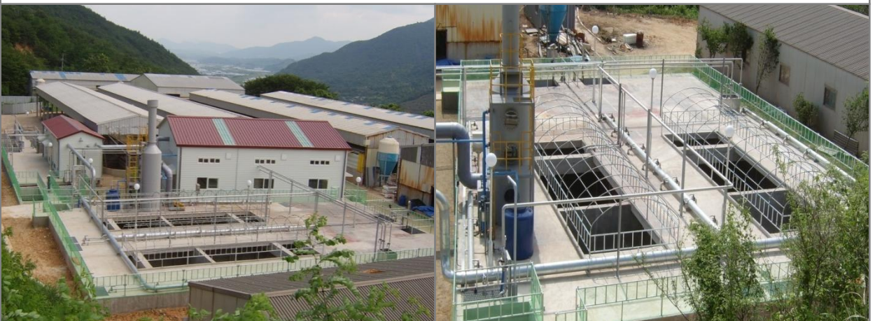
준 공사 진
