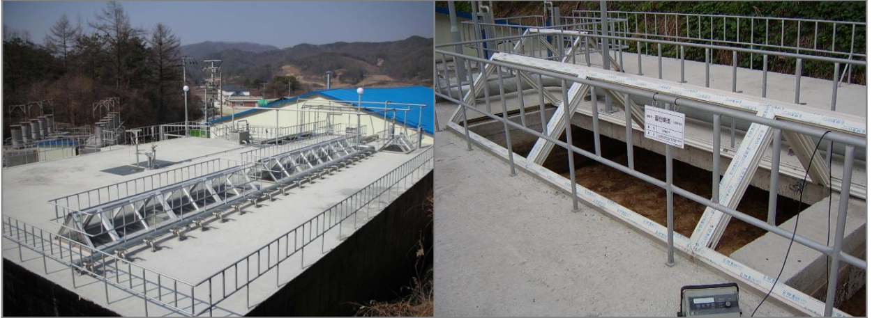
준 공사 진
